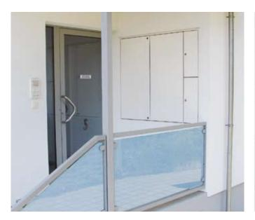
Si l'on souhaite monter le compteur sur la façade extérieure, le coffret à compteur extérieur est idéal. Ce dernier peut intégrer, en plus du compteur, du récepteur de télécommande centralisé et des branchements T+T et TV, le coffret d'abonné apparent type KH.
